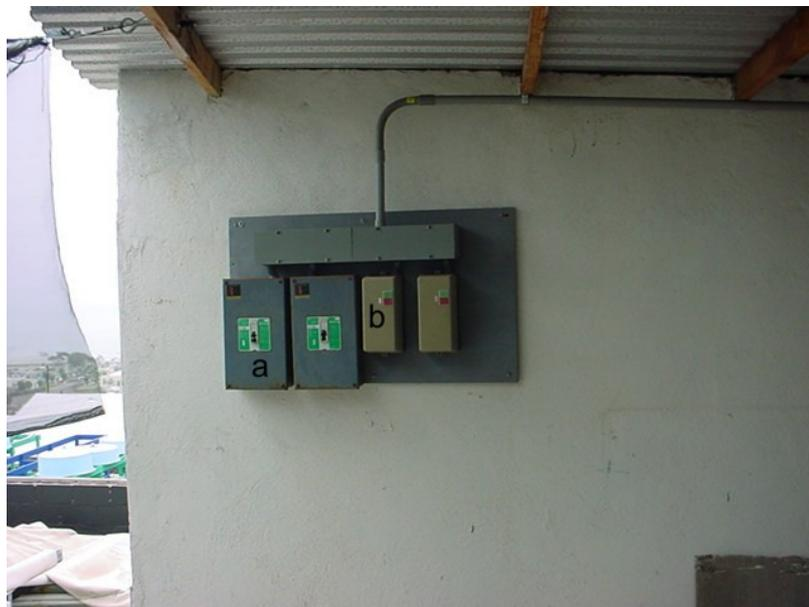
Foto 4. Tablero de control de las dos motobombas de 3 HP. a, protección termo magnética y b, arrancadores eléctricos (Fig. 1 No. III).
