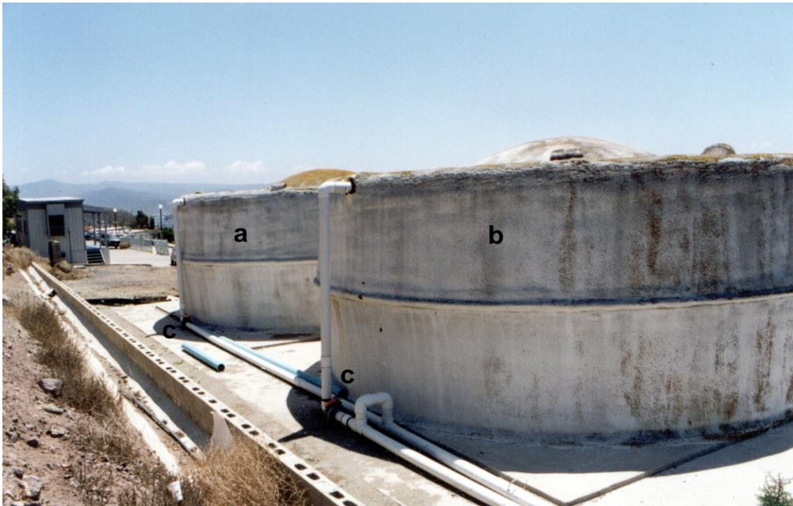
Foto 2. Vista posterior de los estanques de distribución y líneas de suministro hidráulico (Fig. 1 No. I); a, estanque de distribución del sistema de recirculación; b, estanque de distribución del sistema de suministro de agua directamente del océano; c, válvulas plásticas de 10 cm de diámetro.
