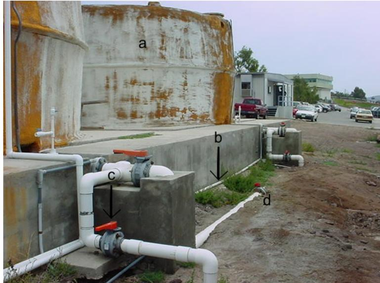
Foto 3. Vista frontal de los estanques de recepción y distribución de agua de mar (Fig. 1 No. I); a, estanque de distribución; b, línea de retorno al estanque de compensación; c, válvulas de vaciado para mantenimiento; d, válvula de ecualización de niveles.
