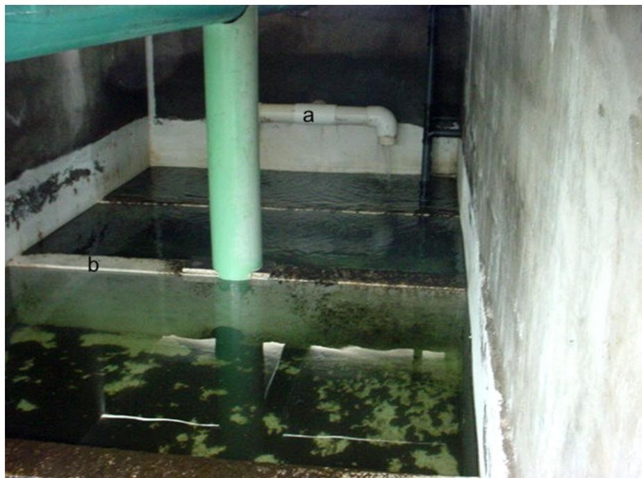
Foto 8. Vista interna del estanque de sedimentación que precipita los sólidos mayores a 100 micras (Fig. 1, No. VI). a, retorno de agua proveniente de los acuarios y estanques de los usuarios; b, pared divisoria entre las cámaras de sedimentación.
