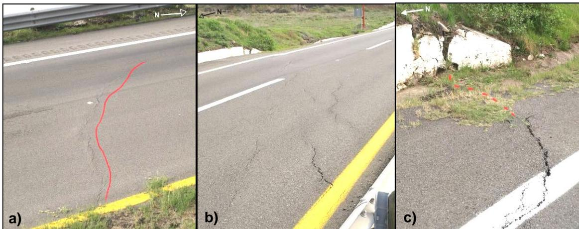
**Figura 41: Fotografías tomadas en el km 90+900 el 20 de enero de 2010 después de lluvias intensas ocurridas en la región. a) Grieta en el cuerpo A de la autopista, la línea roja marca su trazo. b) Grietas en el cuerpo B de la autopista. c) Fractura en el muro de contención en el lado este del cuerpo B de la autopista.**
