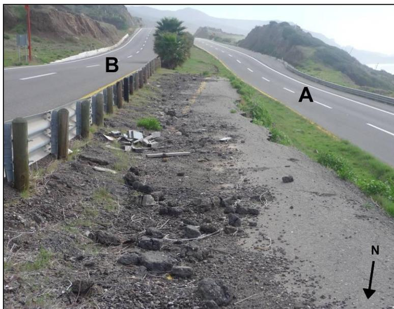
**Figura 43:** Fotografía tomada el 20 de enero de 2010 en el km 89+800. La letra A indica el cuerpo de la autopista que va hacia Ensenada, la letra B señala el cuerpo que va hacia Tijuana. Se aprecia claramente, en el centro de la imagen, el trazo de carretera abandonado.
