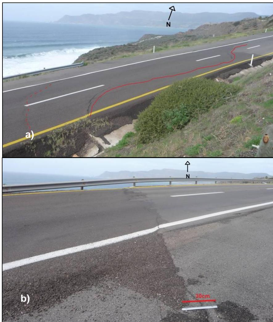
**Figura 42:** Fotografías tomadas en el km 94+200 el 20 de enero de 2010 después de lluvias intensas ocurridas en la región. a) Grietas en el cuerpo A de la carretera, la línea roja continua marca el trazo de la principal, la línea roja discontinua marca el trazo de otra que tiene el mismo rumbo. b) Grieta en el cuerpo B de la carretera, la cual produce un desnivel muy notorio.
