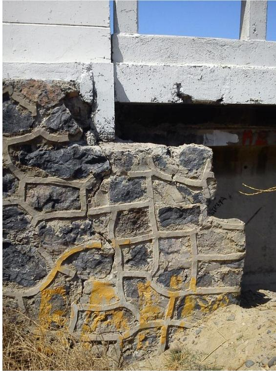
**Figura 8. Agrietamiento en estribo.**
