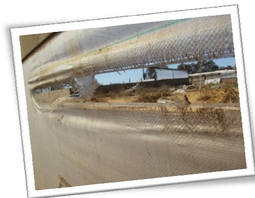
**Figura 41: Ruptura en invernadero.**
