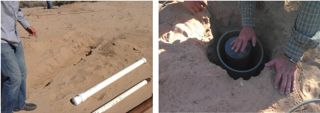
**Figura 24. (Izquierda) Bobina de inducción, protección de PVC y zona excavada para su instalación. Estación CP02. (Derecha) Instalación del equipo fluxgate.**
