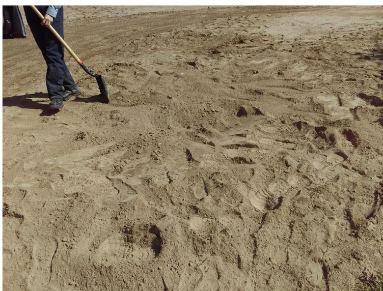
Figura 32. Estado de la estación al terminar el mantenimiento. El equipo se encuentra sepultado, con poca evidencia de la presencia del equipo de trabajo. La presencia de la antena GPS en superficie es casi inadvertida.
