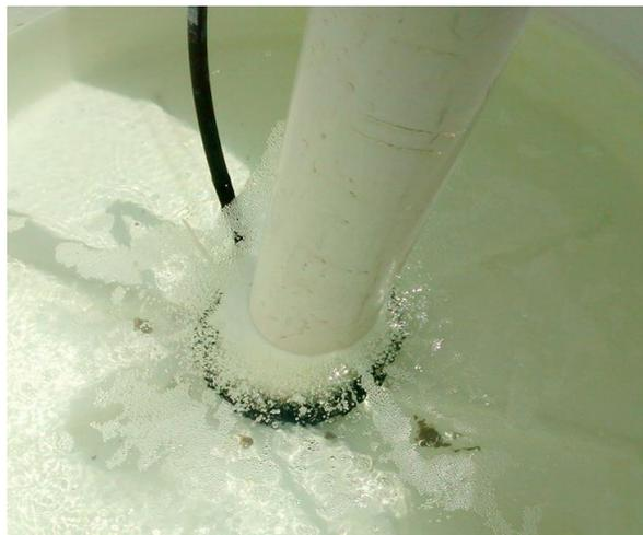
**Figura 4.** Sistema de aireación con manguera Aerotube® de ½ in conectado a un blower de 2.5 HP.
