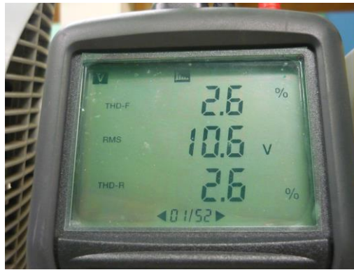
Figura 71. Voltaje de salida del microinversor de 10.6V con una DAT de 2.6%.
