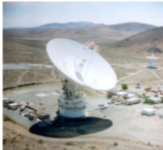
Figura 8. Reflector parabólico de 70 metros de diámetro situado en Goldstone (EUA) (Anguera y Pérez, 2008).
