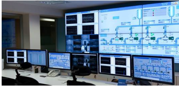
Figura 2. Un centro remoto de control es un ejemplo del tipo de sistemas que se encuentran en la capa virtual de un CPS.
