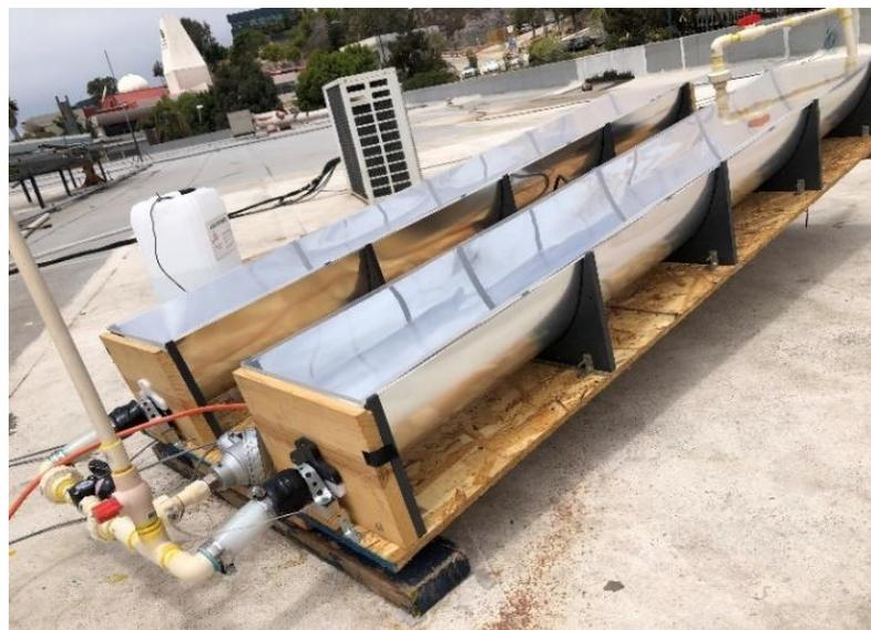
**Figura 34.** Vista lateral del concentrador solar CPC.
