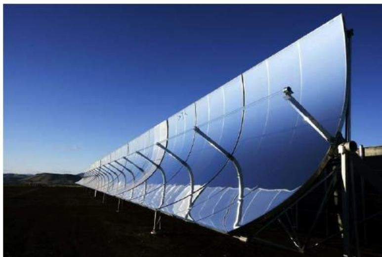
**Figura 4.** Concentradores solares de tiro parabólico (PTC) (Dickes et al., 2015).
