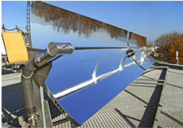
**Figura 12.** Concentrador de tiro parabólico (SPF Institute for Solar Technology | OST, n.d.).
