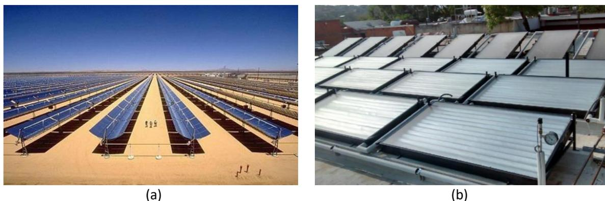
**Figura 11.** Instalación de concentradores solares: (a) PTC y (b) CPC (Gasca, 2013; Santos-González, 2019).
