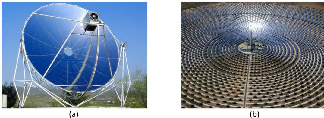
**Figura 10.** Plantas de concentración solar: (a) PDR y (b) Campo de heliostatos (Dabiri & Rahimi, 2016; Kumar et al., 2022).
