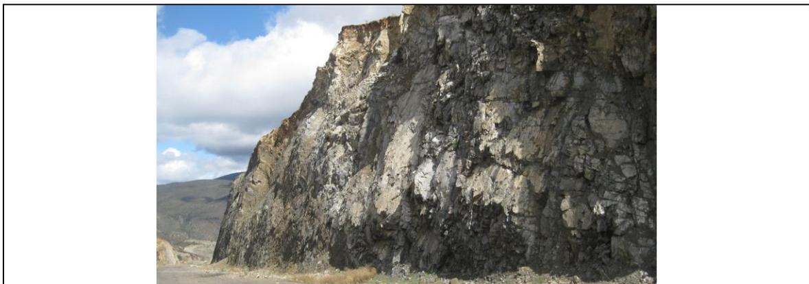
Figura 5. Fotografía del corte de talud en rocas ignimbríticas de aproximadamente 20 m de altura y pendiente casi vertical. Presenta fracturamiento vertical intenso.
